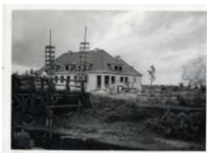
Foto 167. Võiduküla asunduse algkool Pärnumaal. Silla ehitamine maakuivendamise tõttu rajatud Timmkanalile, u 1936. Eesti Ajalooarhiiv, f. 2111, n. 1, s. 15467.
