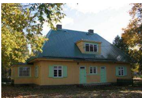
Foto 68. Liivia lastekodu algkool Saaremaal (1926-28). Kalle Kiipus, 2011.
