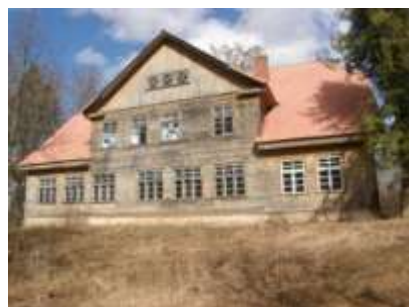
Foto 78. Kõrgepalu Võrumaal (1932). Välja, L., 2007.
