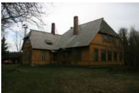
Foto 30. Variku algkool Läänemaal. S. Mälk, 2011.
