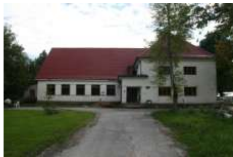
Foto 170. Lepplaane koolimaja korrastatakse ja seatakse elamuks sisse. S. Mälk, 2011.
