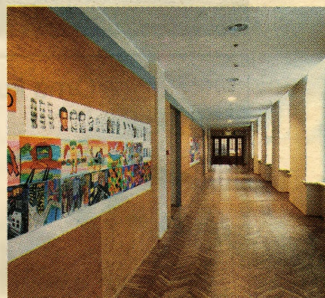
KORIDOR: Ärritavad ripplaud, mis sõidavad kaarakendesse sisse. Kahjuks oli see ainus võimalus ventilatsioonitorude ja muude kommunikatsioonide varjamiseks.
