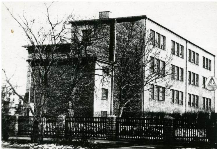
Vaade Tallinna 16. Keskkooli hoonele trammitee ja kooli aia poolt. Keemiaklassi aknad olid vasakul, 1. korrusel
