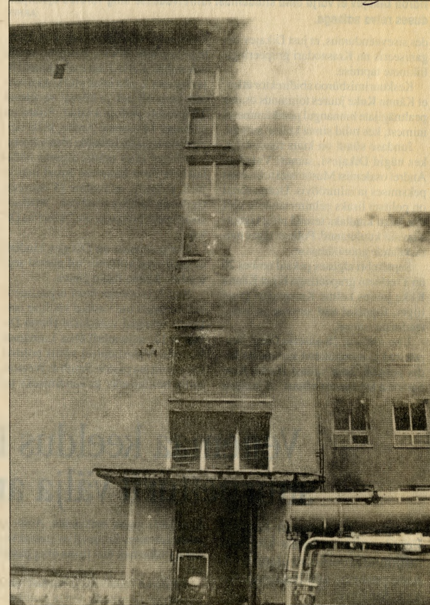
Tuleroaks langenud Saaremaa Ühisgümnaasiumis algab esmaspäeval taas õppetöö. Esimesed kaks korrust tuli põhjalikult remontida.
