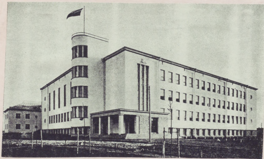
Rakvere ühisgümnaasiumi hoone, mis valmis 1939. Näide moodsast koolimajaehitusest iseseisvas Eestis.
